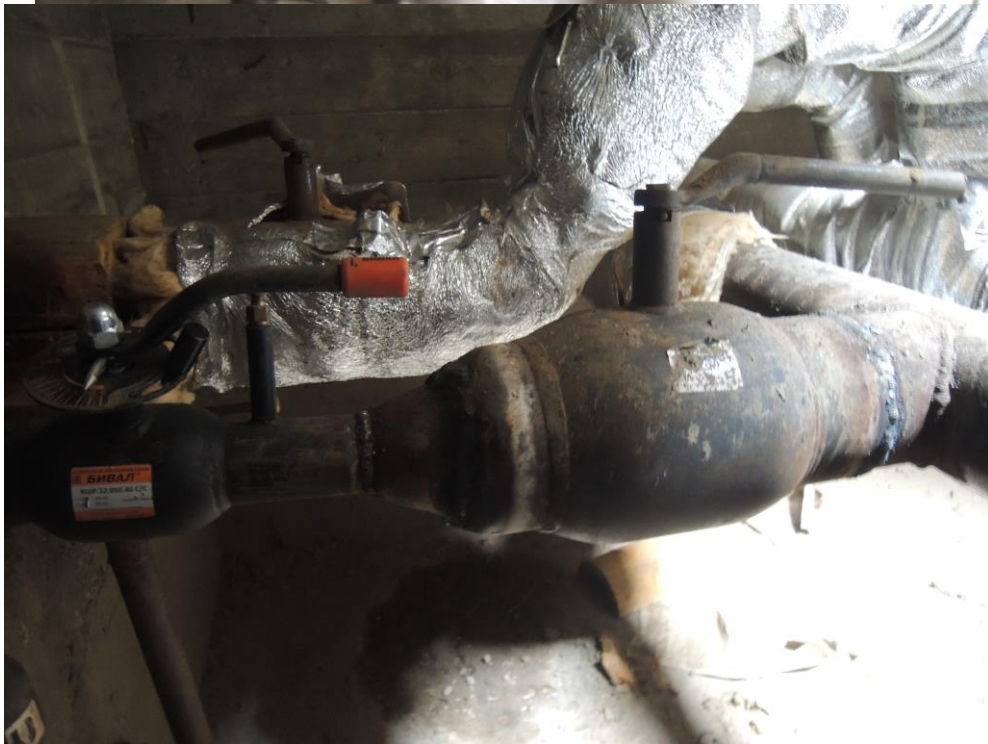
Иллюстрация № 6 Факт изменения диаметров т/трассы и монтажа крана Ду 50
