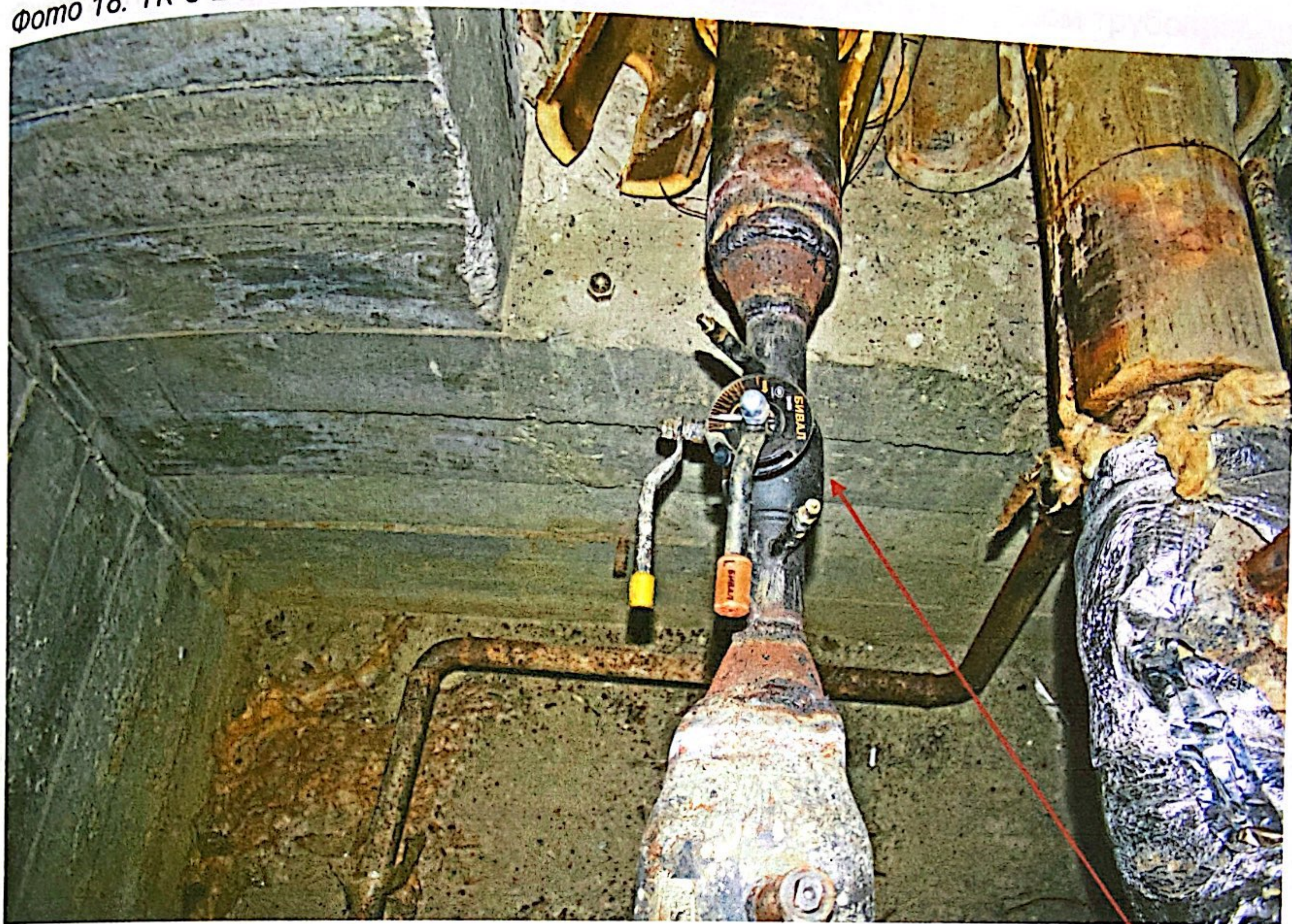
Балансировочный клапан Ду 50 мм на обратном трубопроводе
